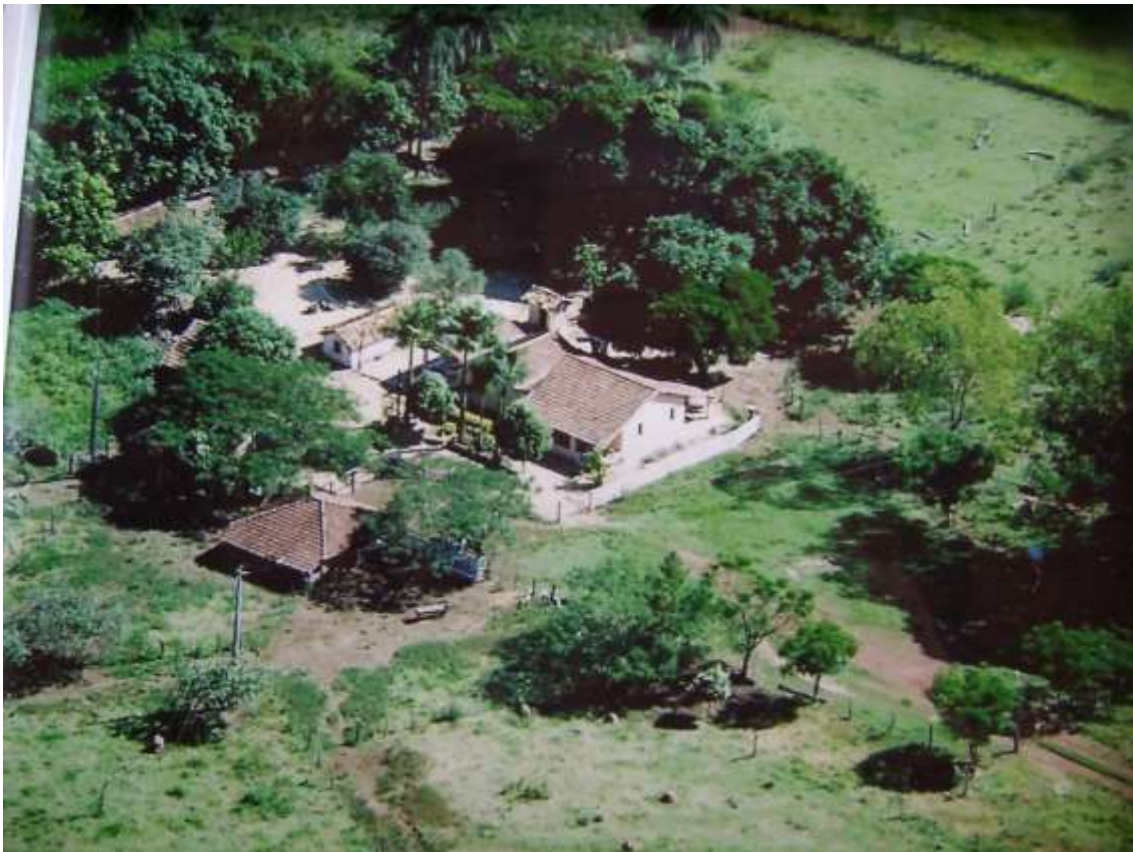
Fazenda Guariba, zona rural, foto aérea de 2019. Setor de Patrimônio Cultural
